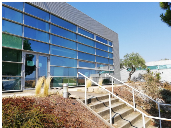
Locaux accessibles aux PMR (Entrée Amphithéâtre B)
