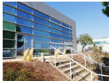
Locaux accessibles aux PMR (Entrée Amphithéâtre B)
