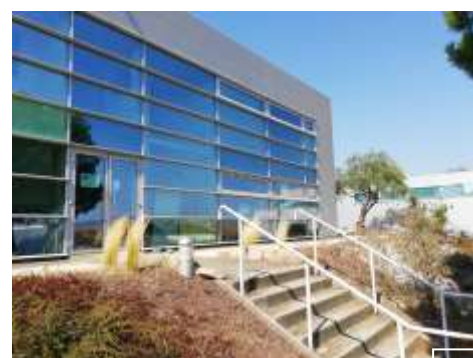
Locaux accessibles aux PMR (Entrée Amphithéâtre B)
