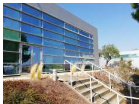
Locaux accessibles aux PMR (Entrée Amphithéâtre B)
