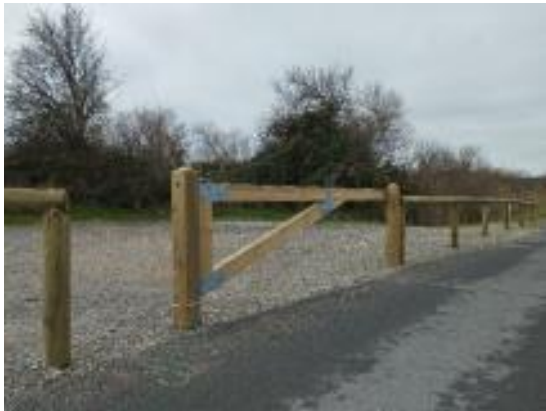
Barrière véhicule installées à l'automne 2022
